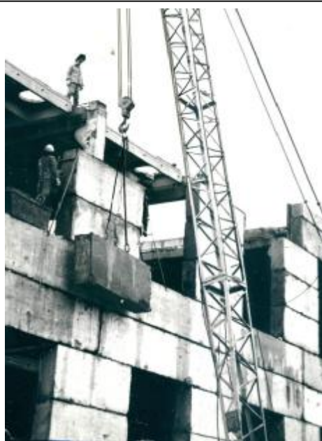
Строительство нового здания швейной фабрики.
