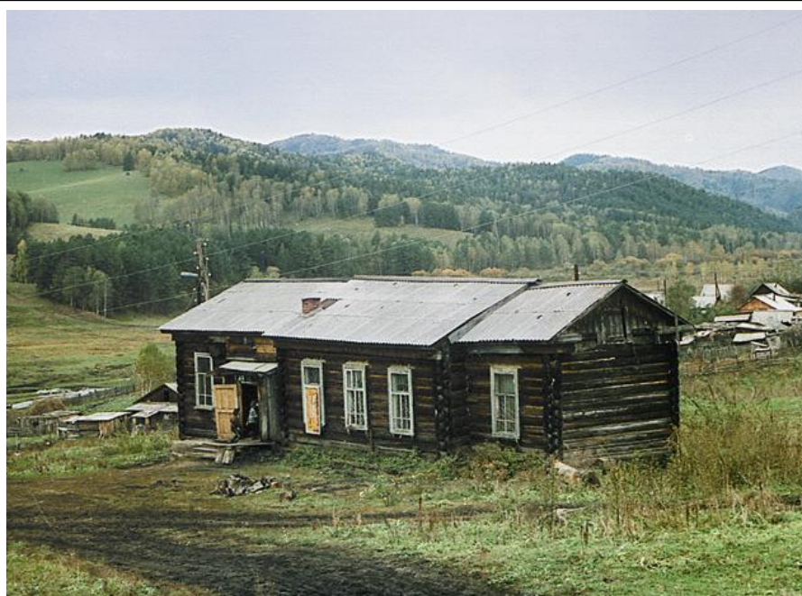
Современный вид бывшей Александро-Невской церкви.
